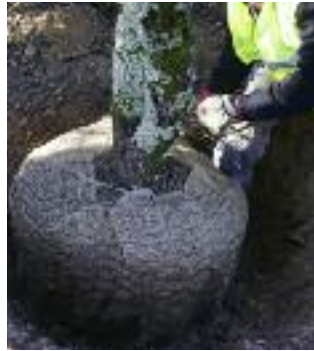
Col·locació de la malla metàl·lica. Autor: J.M. Tusell
